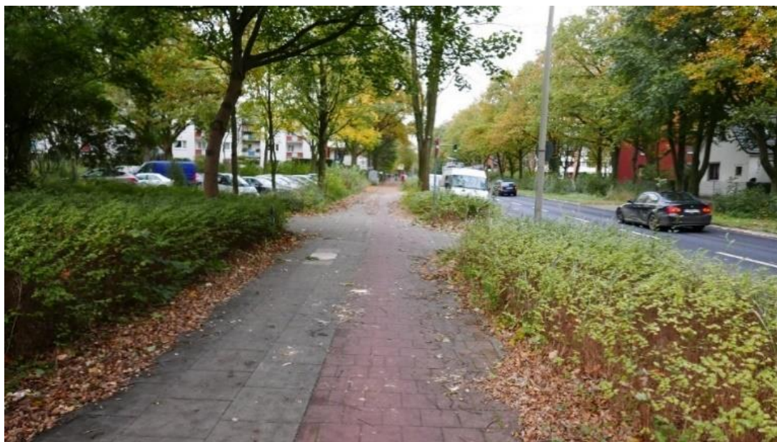
Abbildung 6: Nebenanlage an der Elbgaustraße; Quelle: BPR
